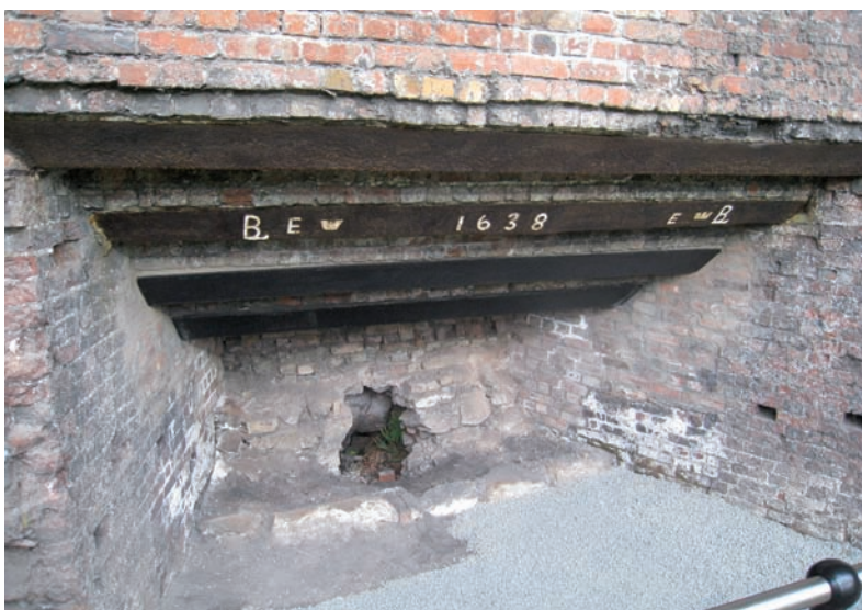
Het gietwerk voor de Iron Bridge is uitgevoerd bij 'The Old Furnace' in Coalbrookdale. Zichtbaar is de opening voor de blaasbalg van deze hoogoven
