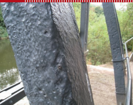
Het is opmerkelijk dat de Iron Bridge, na ruim 200 jaar nog in goede staat is. Het oude gietijzer is kennelijk goed bestand tegen corrosie
