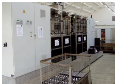
De hardverchrom-machine van Enthone voorkomt chroom-emissies (foto: Cookson Electronics Enthone)
