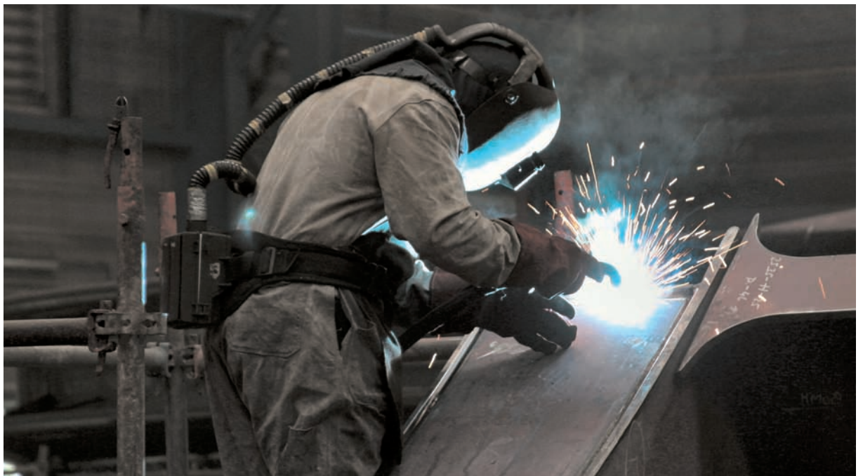
Het lassen van hogesterkte staal vergt vaardigheid en discipline van de lasser (foto: Huisman)
